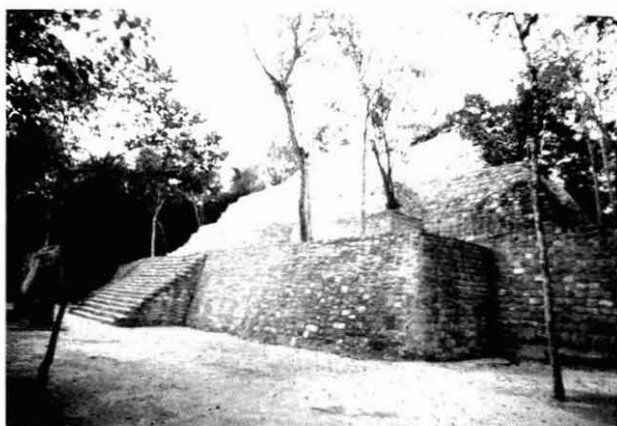
Vista general de la estructura VII
