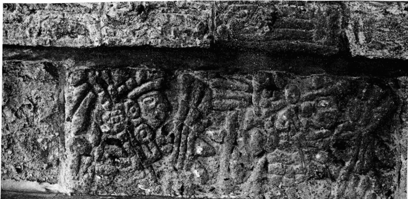
Figuras 10 y 11 (de izquierda a derecha) de la banqueta noroeste del vestíbulo 1, Pirámide B, llamada "Friso de los Caciques", Tula, Hidalgo. (Nótese el desgaste causado por los efectos de la intemperie y las partes blanquecinas que se deben al cemento volátil impregnado)
