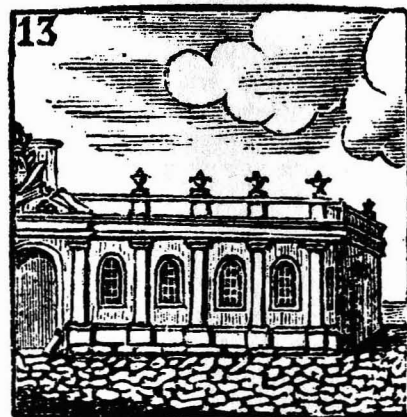
Antigua fundición de cañones.
