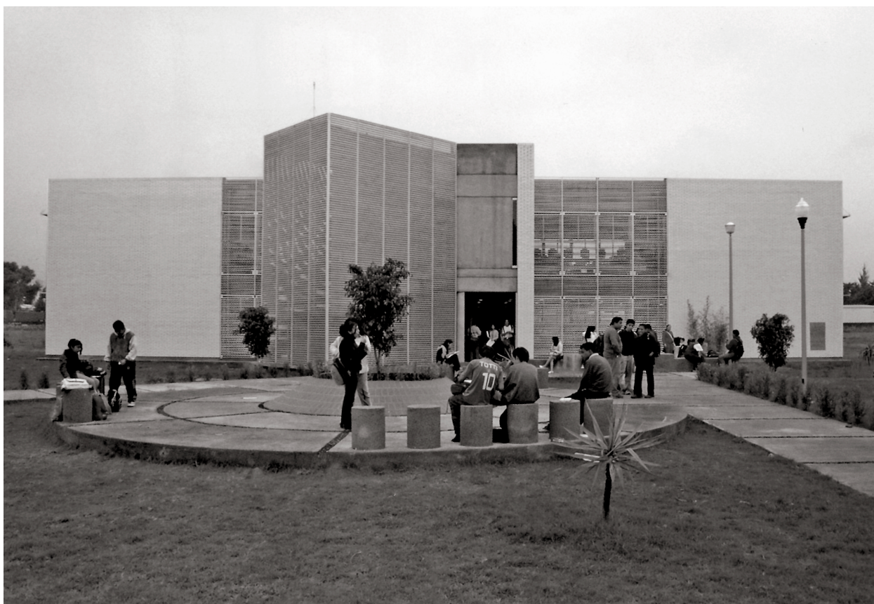
Colegio de Ciencias y Humanidades, laboratorio de cómputo, Plantel Oriente
