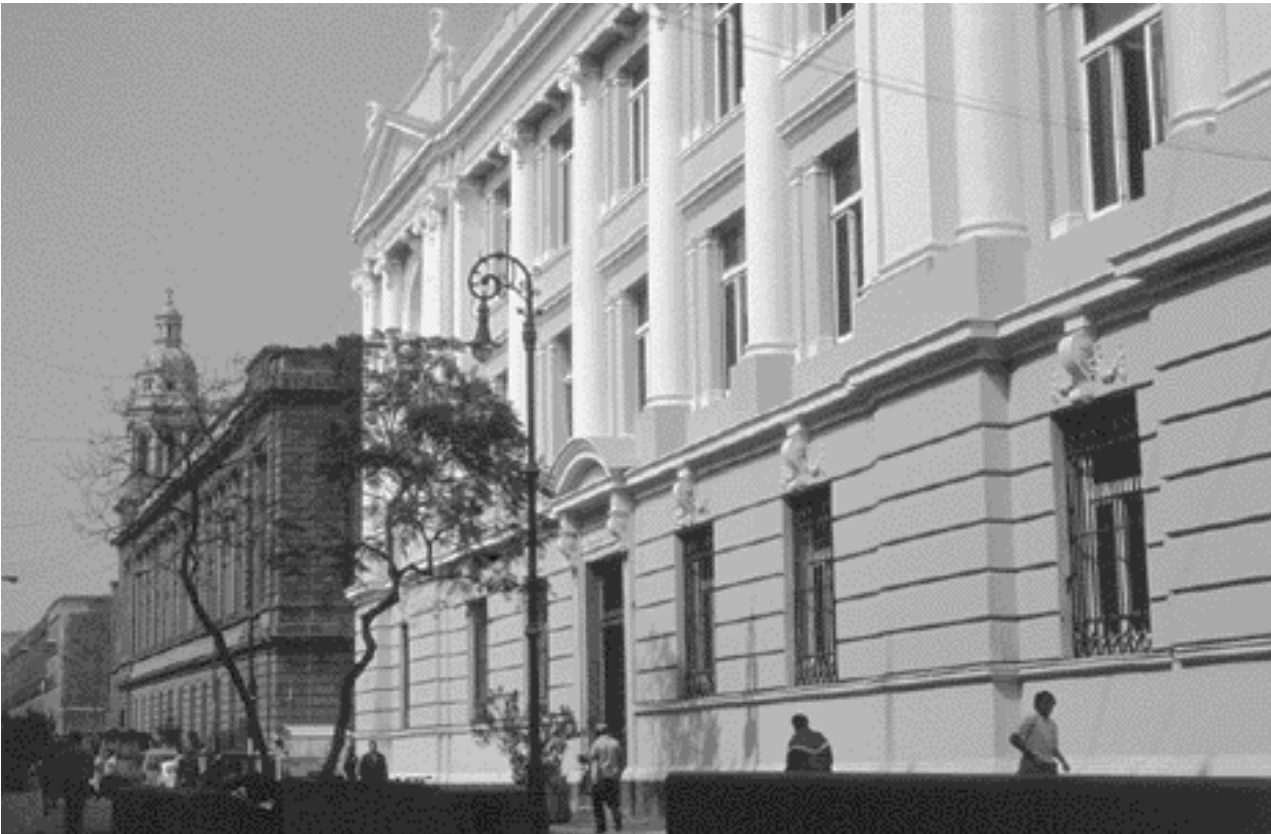
Antigua Escuela de Jurisprudencia
